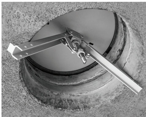
Рисунок 4.2 – Блокировка рычагов УЗНК относительно конструктивных элементов колодца
