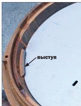
Рисунок 4.1 – УЗНК, установленное в корпус люка под его выступ
